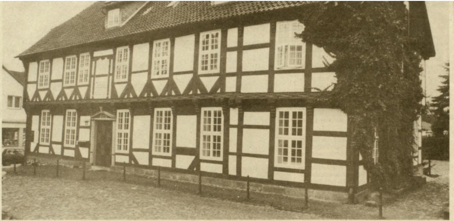
Das Amtshaus in Bissendorf wurde 1691 als Jagdschloß erbaut. Heute ist hier unter anderem die Sozialstation der Gemeinde Wedemark untergebracht. Balken und Balkenköpfe weisen Renaissanceornamente auf. Aufn. (4): Heinz Koberg
